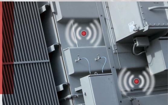
安装好备用人孔盖后，再将传感器安装在油箱顶部的备用手动检修盖上。油仅在人孔盖下方数厘米低的位置排放，从而尽可能减少断电次数。
