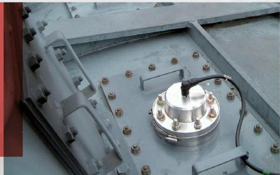
Qualitrol的放油阀传感器可轻松快速地改造安装在现有的变压器放油阀/过滤阀上。
