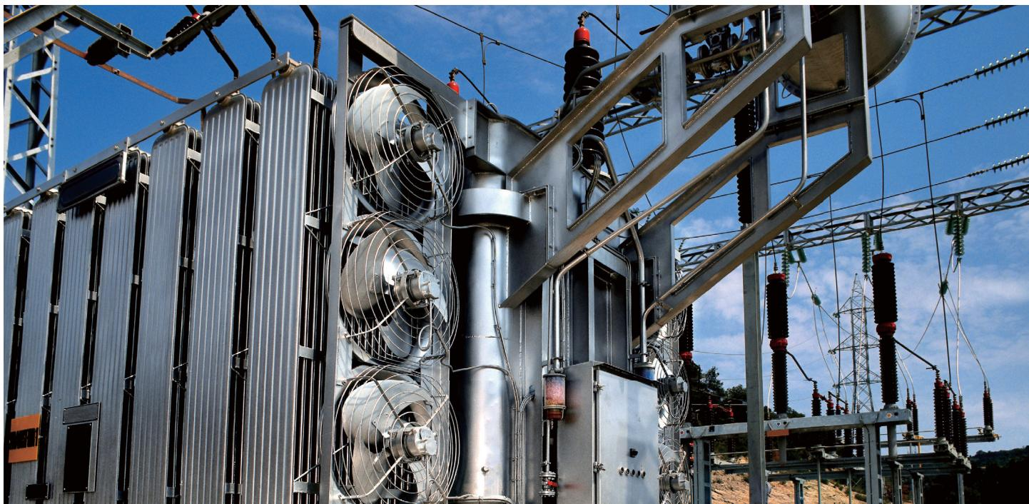
QPDM系统采集UHF传感器的信号，并通过滤波处理排除干扰（噪声），生成PD活动的模型。这些模型可通过ANN（人工神经网络）算法进行分析，确定其是否因PD活动引起。可保存PD幅值、放电率和PD信号持续时间，用于趋势分析、警报和报告功能。
